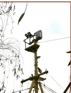
tran operativas las tres nuevas cámaras instaladas en la Pluma de guardería, las mismas permiten una visibilidad de 360°, aportando una visión completa de las marinas 4, 5 y 6, la barcaza de trabajo
